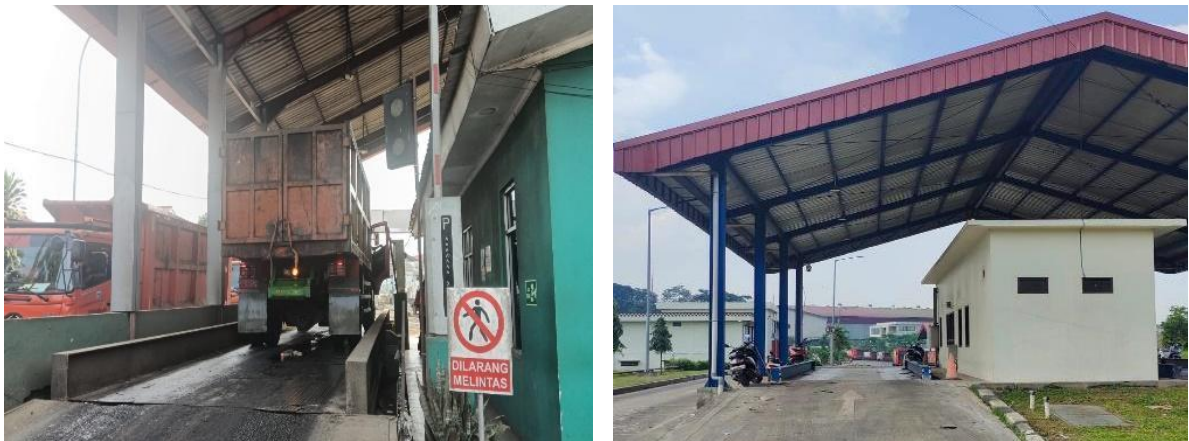
Gambar II-13. Jembatan Timbang Bantargebang
