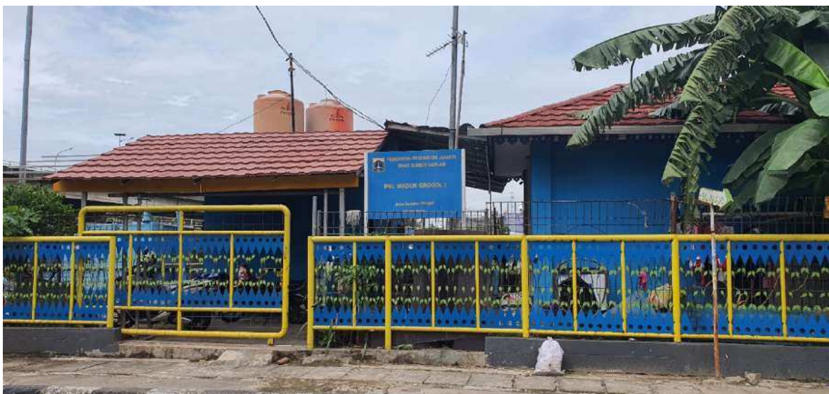
Gambar 3.244. Contoh fasilitas IPAL Interceptor di Waduk Grogol.
