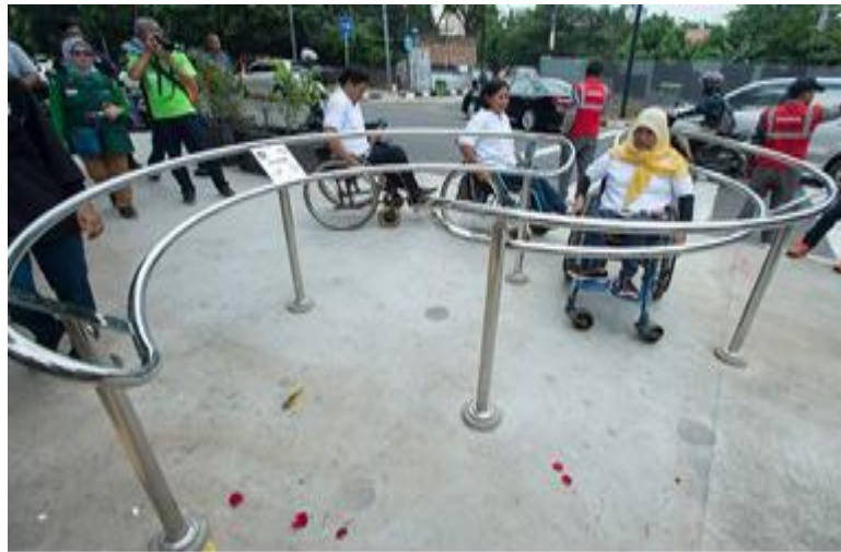
Gambar 194. Trotoar didepan RSCM telah memenuhi standar ramah difabel dan memiliki Portal S untuk memudahkan penggunaanya
