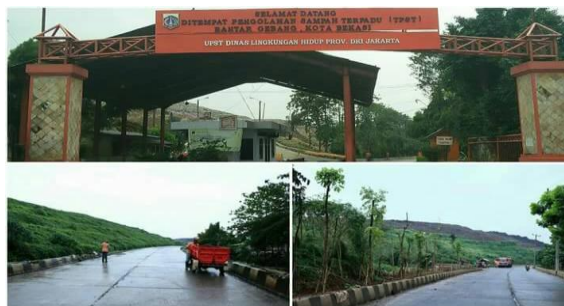
Gambar 179. Kondisi TPST Bantar Gebang, Kota Bekasi setelah dibawah Dinas Lingkungan Hidup Provinsi DKI Jakarta
