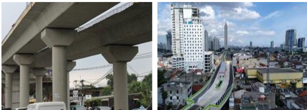
Gambar 192. Pembangunan Jalan Layang Khusus Ciledug – Tandean sepanjang 9,3 km
