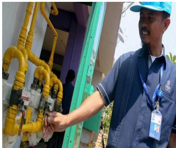
Gambar 197. Pemasangan Pipa Gas Pada Rumah Susun
