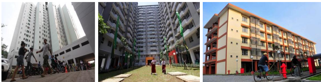
Gambar 11. Rumah Susun Jatinegara, Rumah Susun Angke dan Rumah Susun Cipinang Muara
