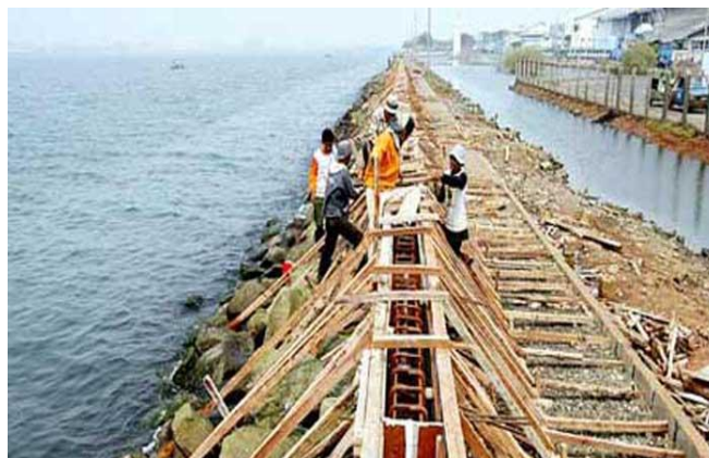
Gambar 176. Pembangunan Tanggul Fase A NCICN di Muara Kali Blencong, Marunda, Cilincing
